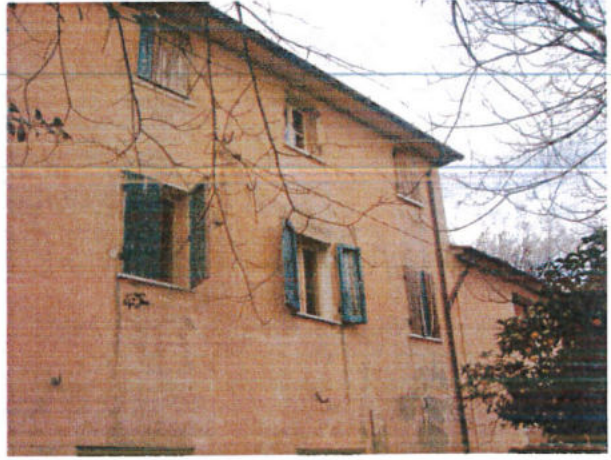
Prospetto lato Nord
